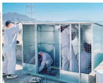
ゴミステーション設置
