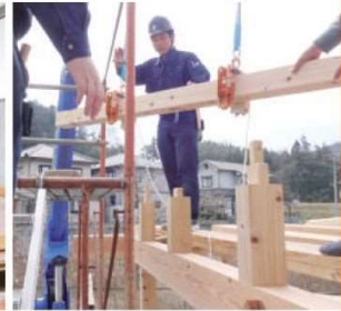
模擬家屋棟上げ実習
