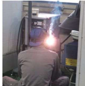
被覆アーク溶接作業
